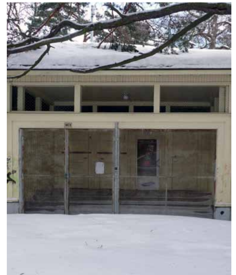
Pääsisäänkäynnin yhteyteen on ilmeisesti jälkikäteen asennettu lukittavat metalliset ritiläportit.
