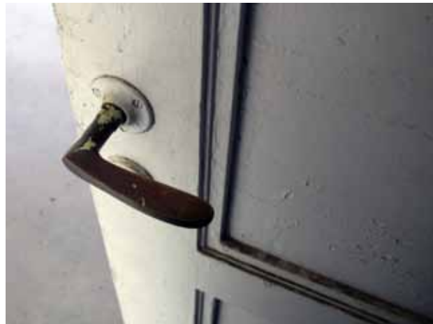
Ulko-ovien heloituksia. Rakennuksen ovet ja ikkunat olisivat kunnostuksen tarpeessa ja niiden helat tulisi huoltaa.
