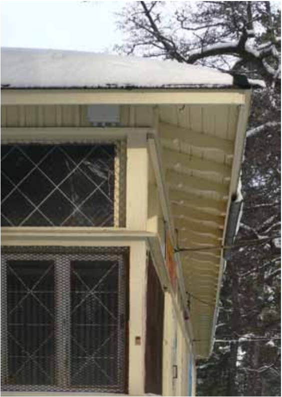
Ikkunat ja valoaukot on suojattu kauttaaltaan verkoilla. Vain uudella puolella aukoissa on ikkunat. Ikkunaliittymät on esitetty ulkoseiniä käsittelevässä kohdassa.
