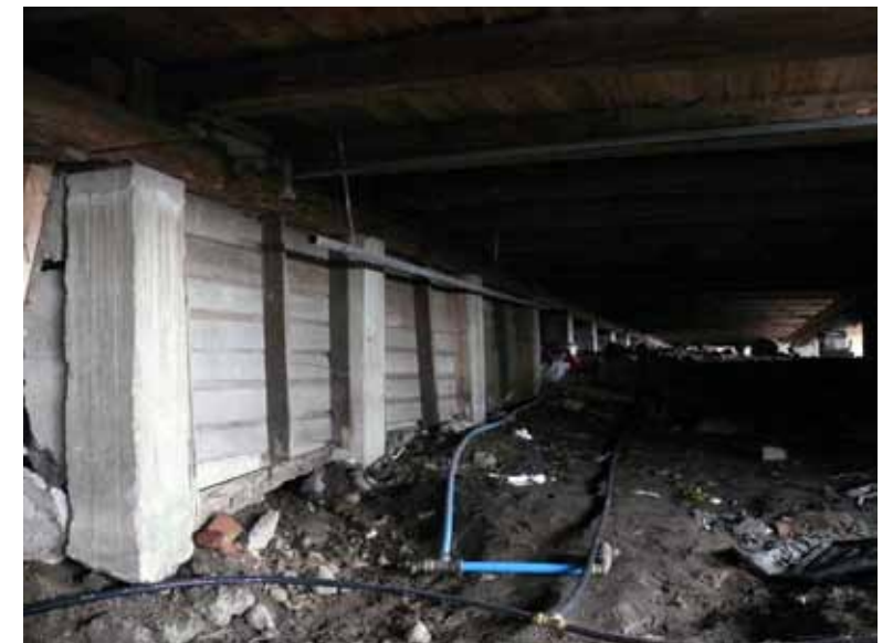
Tämä perustuksen "puuverhous" paljastuu lähemmässä tarkastelussa paikalleen jätetyksi perusmuurin valumuotiksi.
