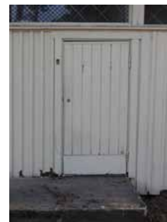
Pukuhuoneen sisäovi sekä kahvilan takaulko-ovi.
