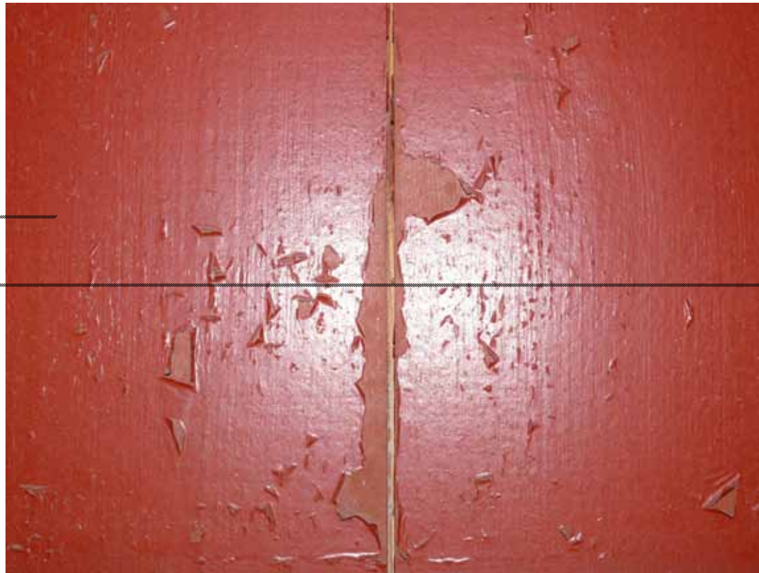
Ulkoseinän sisäpinta rakennuksen vanhassa päädyssä
