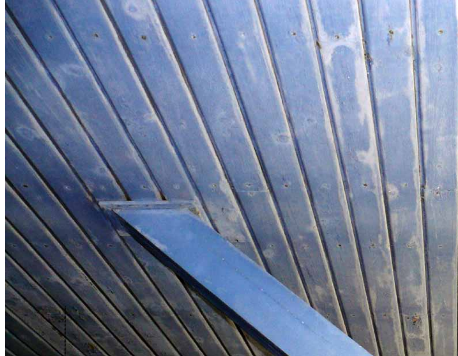
Alakattopanelointi vanhassa pukusuojaosassa.
