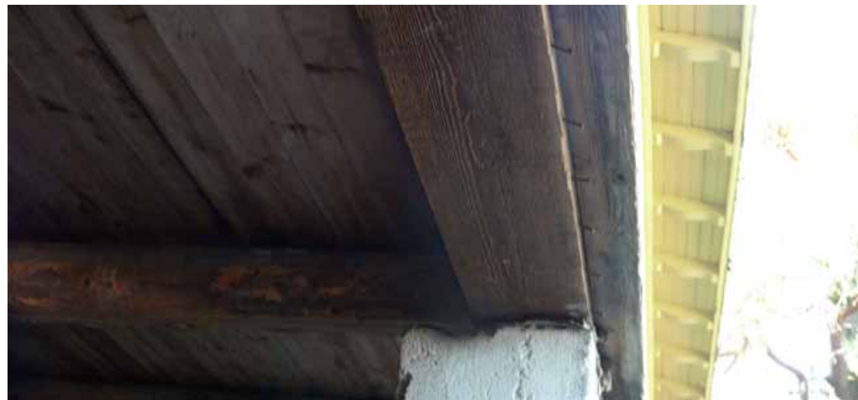
Julkisivun alla alapohjapalkkina toimii 7" parru, johon vesilauta on kiinnitetty. Parruun lyödyt naulat ovat jäänteitä sokkelia peittäneestä säleiköstä.
