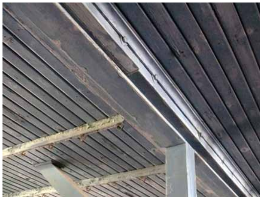
Sisäkaton paneelit on naulattu varsin tiheästi yläpuolisiin kantaviin rakenteisiin. Kannatus tukeutuu paviljongin harjalinjan kohdalla kulkevaan järeään palkkiin. Kaksi pulteilla vierekkäin liitettyä 6" parrua on naamioitu veistoksellisesti laudalla ja kattolistoilla.
