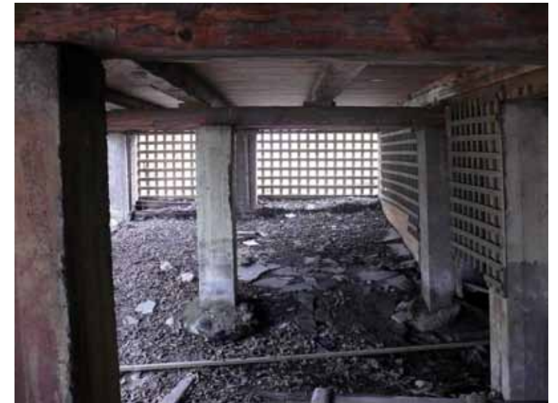
Ryömintätila on itäpäädyssä korkea ja toiminut ajoittain ilmeisesti laitapuolen kulkijoiden yöpaikkana.
