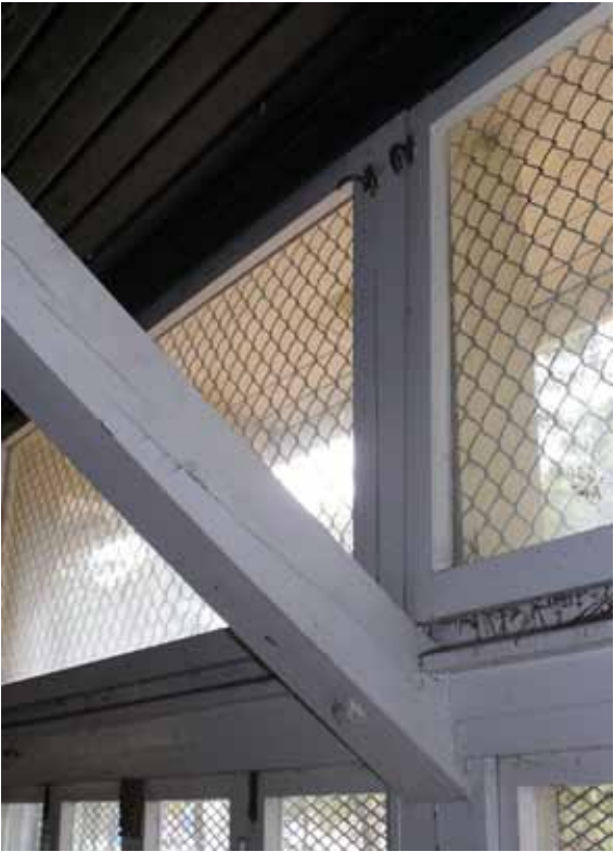
Kahvilan ikkunoiden heloituksia. Yläikkunat on salvattu vain yläreunastaan ja alareuna tukeutuu kattoristikon vinosauvoihin.
