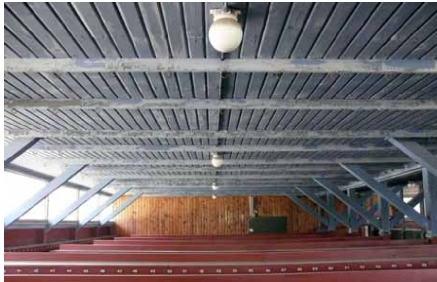
Kattopaneelien alapuolella sijaitsevat juoksut eivät kannattele sisäkattoja, vaan toimivat ripustuskoukkujen kiinnitysalustana.
